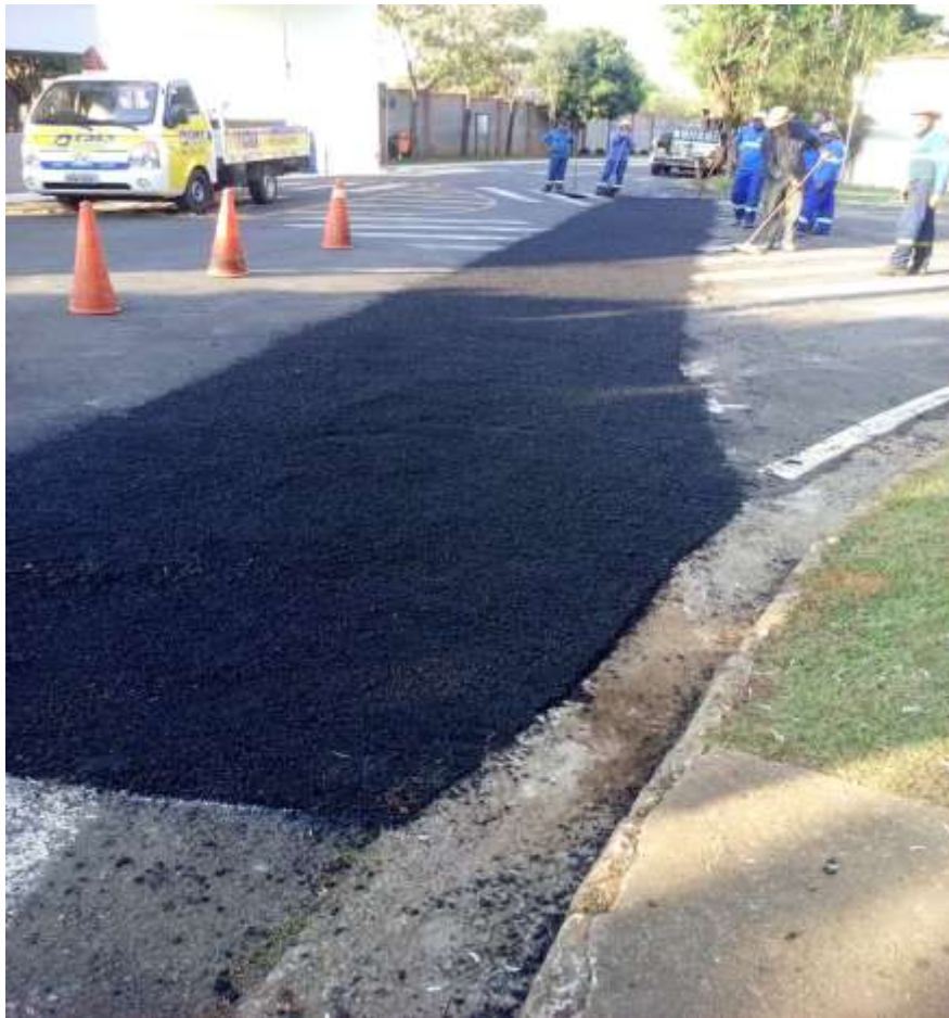
Recapeamento na avenida
