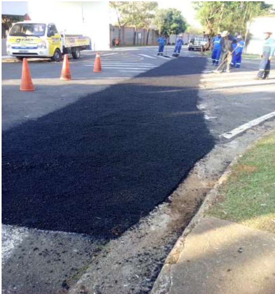
Recapeamento na avenida
